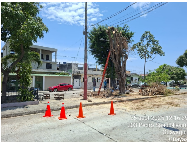
Extracción de árboles en estado necrótico
